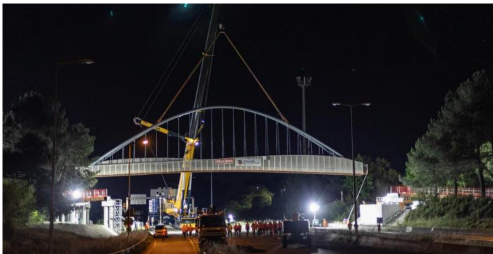
Figure 110 : Grutage de la passerelle PESSAC (33) surplombant l'A630
