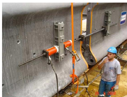
Figure 121 : Assemblage des éléments unitaires BFUP par post tension sur site
