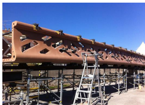
Figure 120 : Passerelle BFUP Cannet des Maures (83) – aire d'assemblage
